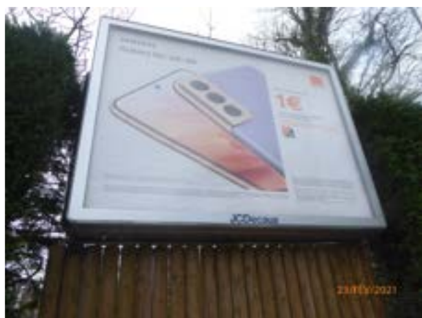
Dispositif scellé au sol avec affiche de 8m 2 (soit 10,50m 2 avec le cadre), habillé d'une clôture, route de Mantes
